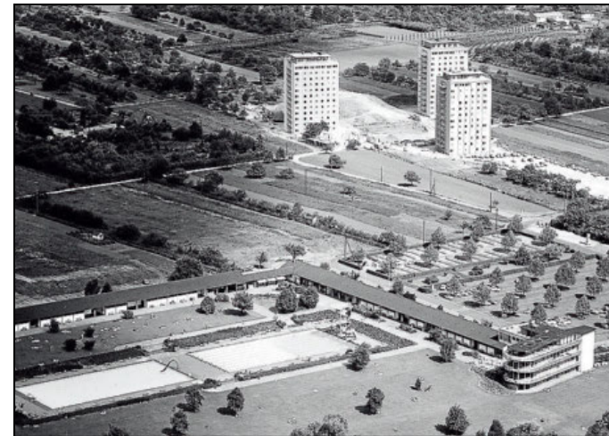
1962 errichtete das Studentenwerk drei Wohnheimshochhäuser im Neuenheimer Feld unweit des Tiergartenbades. Foto: Ehhalt
