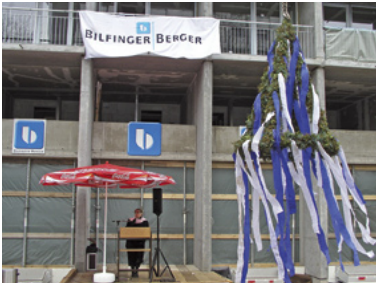
Richtfest beim Neubau Im Neuenheimer Feld 129
