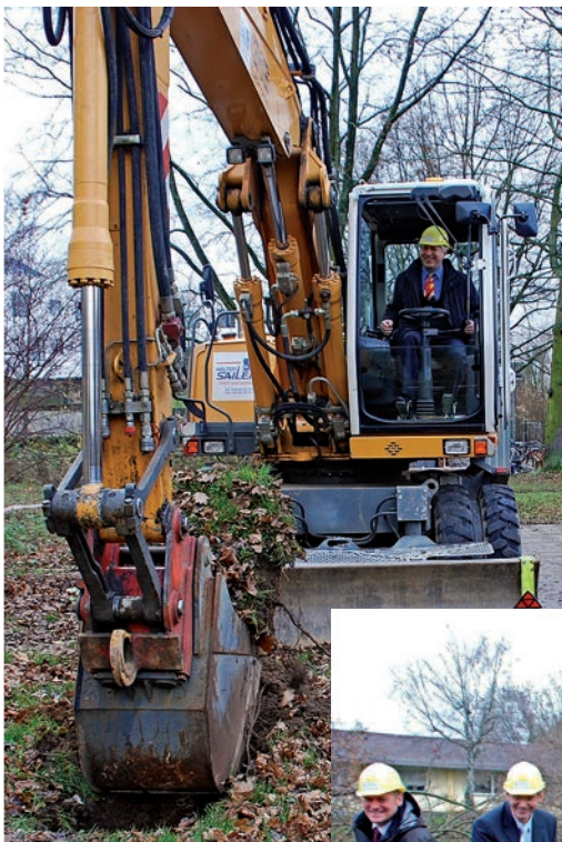
Spatenstich am Klausenpfad: Der Rektor der Universität Heidelberg, Prof. Dr. Bernhard Eitel, hob mit dem Bagger das erste Stück Erde aus
