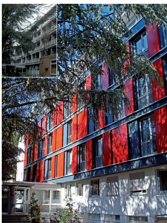
Energetisch saniert – Das Comeniushaus erfüllt hohe Umweltstandards
